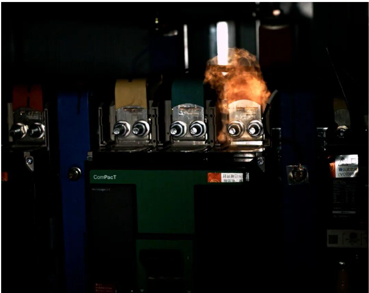
Figura | Istante dell'esplosione causata da sovraccarico del relè
